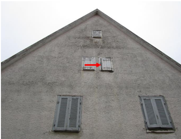
Abb. 6: Potenzieller Zugang zum Dachgeschoss des Wohngebäudes
