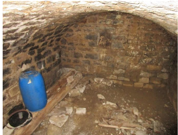
Abb. 5: Gewölbekeller unterhalb der Garage im Südwesten
