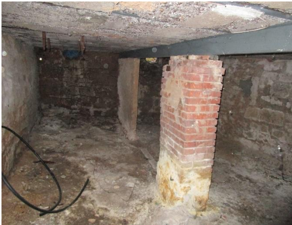
Abb. 4: Keller des Wohngebäudes
