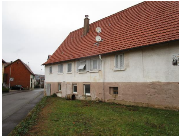
Abb. 2: Wohnhaus mit Trittrassenfläche.
